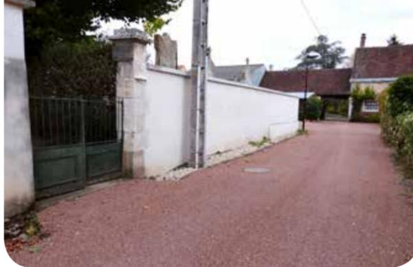
L'allée du Colombier a elle aussi été reprise intégralement. Un reprofilage et un revêtement bicouche ont été réalisés par l'entreprise ETPB. Sur la photo ci-jointe, on peut également voir le mur de l'ancien cimetière refait au printemps.
