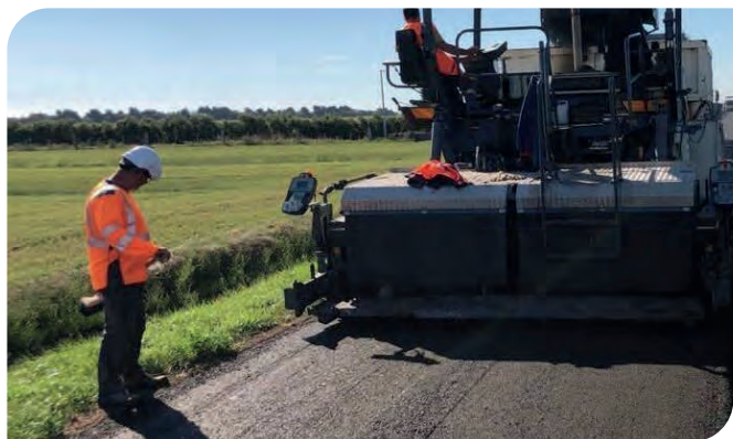
Réfection d'une portion de voirie de la route des Cailloux (entre les Groseilliers et la Barcelle)
