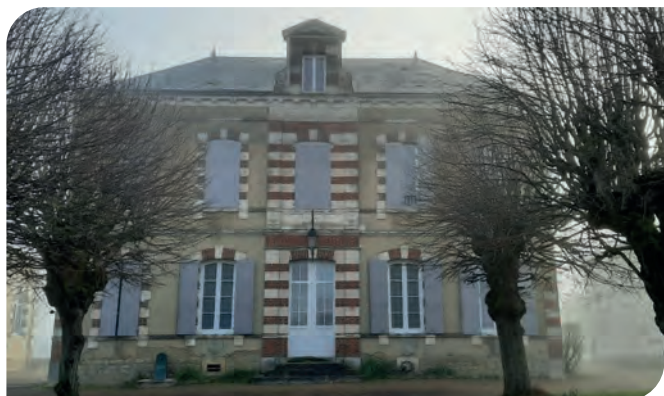
Réfection façade de la mairie pour une harmonisation des bâtiments municipaux
