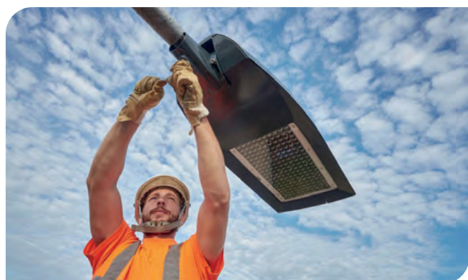
Passage en luminaires Led de l'éclairage public
