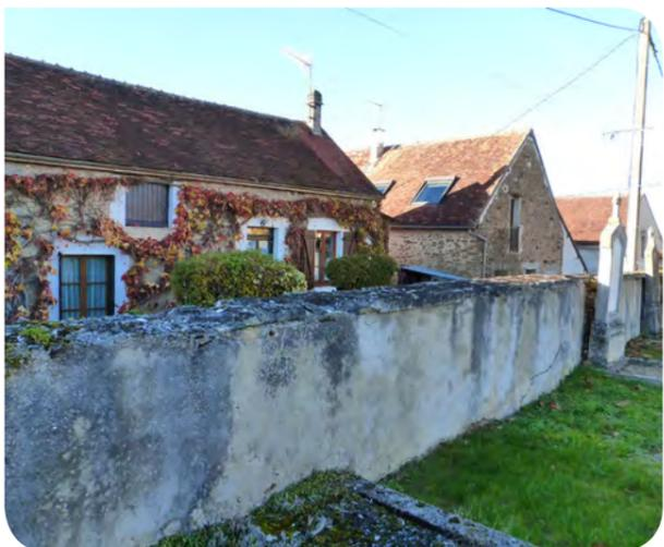
Une partie du mur de l'ancien cimetière situé allée du Colombier nécessite une remise en état pour éviter que les infiltrations d'eau accentuent son délabrement. De nouveaux chapeaux de mur vont être posés, les fissures rebouchées et l'enduit refait. Ces travaux ont été confiés à l'entreprise TAUPIN pour un montant de 9 675 € HT.
